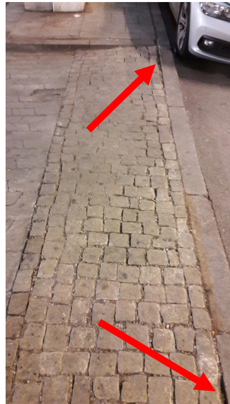
Fotos (von Leo Meyer-Giesow): Oben, mit Pfeil markiert: Abzusenkende Bordsteine vor Haus Helene-Mayer-Ring 14 Unten links, mit Pfeil markiert: Abzusenkende Bordsteine vor Haus Nadistraße 3a Unten rechts: Mangelhafte Verfugungen, besonders zwischen Kleinsteinpflaster und Bordsteinen
