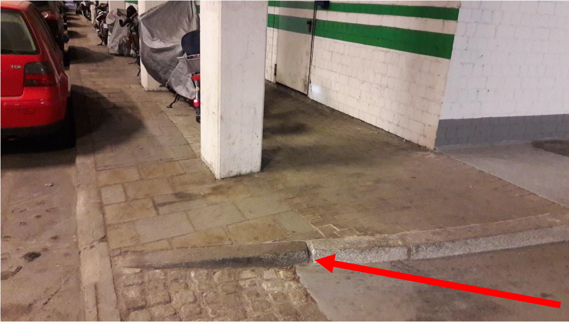
Fotos (von Leo Meyer-Giesow): Oben, mit Pfeil markiert: Abzusenkende Bordsteine vor Haus Helene-Mayer-Ring 14 Unten links, mit Pfeil markiert: Abzusenkende Bordsteine vor Haus Nadistraße 3a Unten rechts: Mangelhafte Verfugungen, besonders zwischen Kleinsteinpflaster und Bordsteinen
