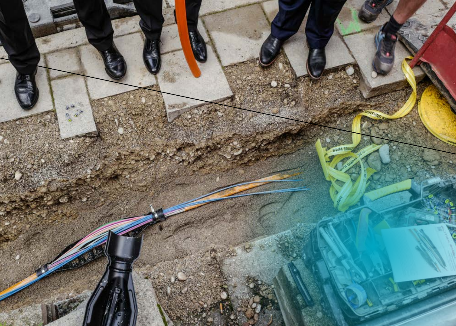
Abb. 47 Der Ausbau des High-Speed-Glasfasernetzes in München geht voran. 2022 kamen rund 70.000 Haushalte dazu.
