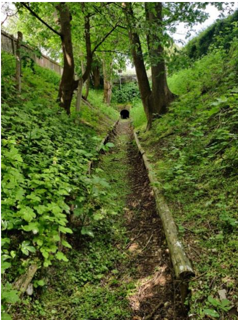
Nördlicher Bereich, Salzmesserstraße
