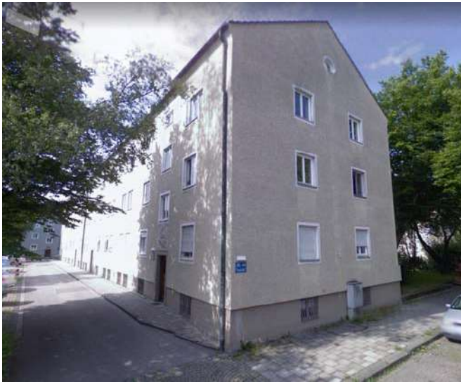
Abbildung 4: Außenansicht Wohngebäude in der Triesterstraße 38-44 (Quelle: Google Street View)
