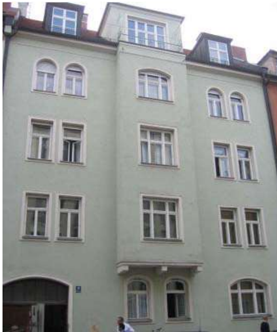
Abbildung 3 Außenansicht Wohngebäude in der Tattenbachstr.10 (Quelle: GWG)
