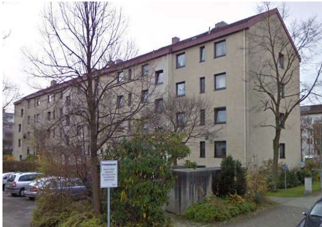
Abbildung 6 Außenansicht Wohngebäude 80er Jahre im Erwin-von-Steinbach-Weg 21-25 (Quelle: GWG)
