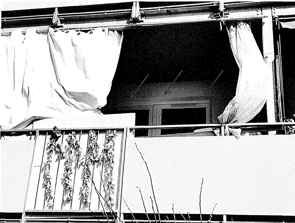
**Wohngebäude der GWG in der Dachauer Straße 401 bis 403:** Auf Rollläden oder außenliegenden Sonnenschutz wurde verzichtet. Statt dessen gibt es auch hier eine zu hohe Brandlast durch brennend abtropfende Kunststofffolien, Balkonverkleidungen aus Kunststoff und Wärmedämmverbundsystem aus Polystyrol. **Ein Nachrüsten der Fenster mit außenliegendem Sonnenschutz und eine Überprüfung des vorbeugenden Brandschutzes wird beantragt.**
