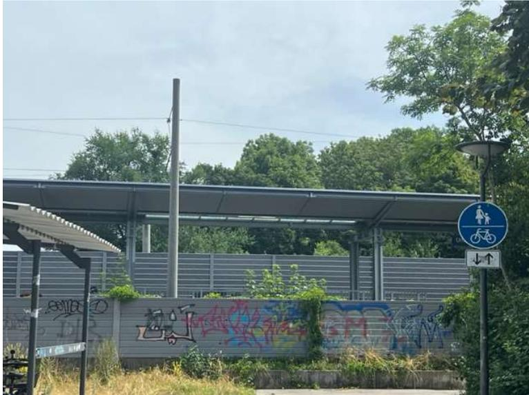
Anhand der Bilder (oberes Bild öffentlich aus dem Internet) ist zu erkennen, dass die Lärmschutzwand an der Ostseite ab Bahnsteigniveau eine Höhe von ca 3 Metern hat.
