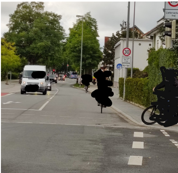
Straßenabschnitt Truderinger Straße bei Gebäude 271.
