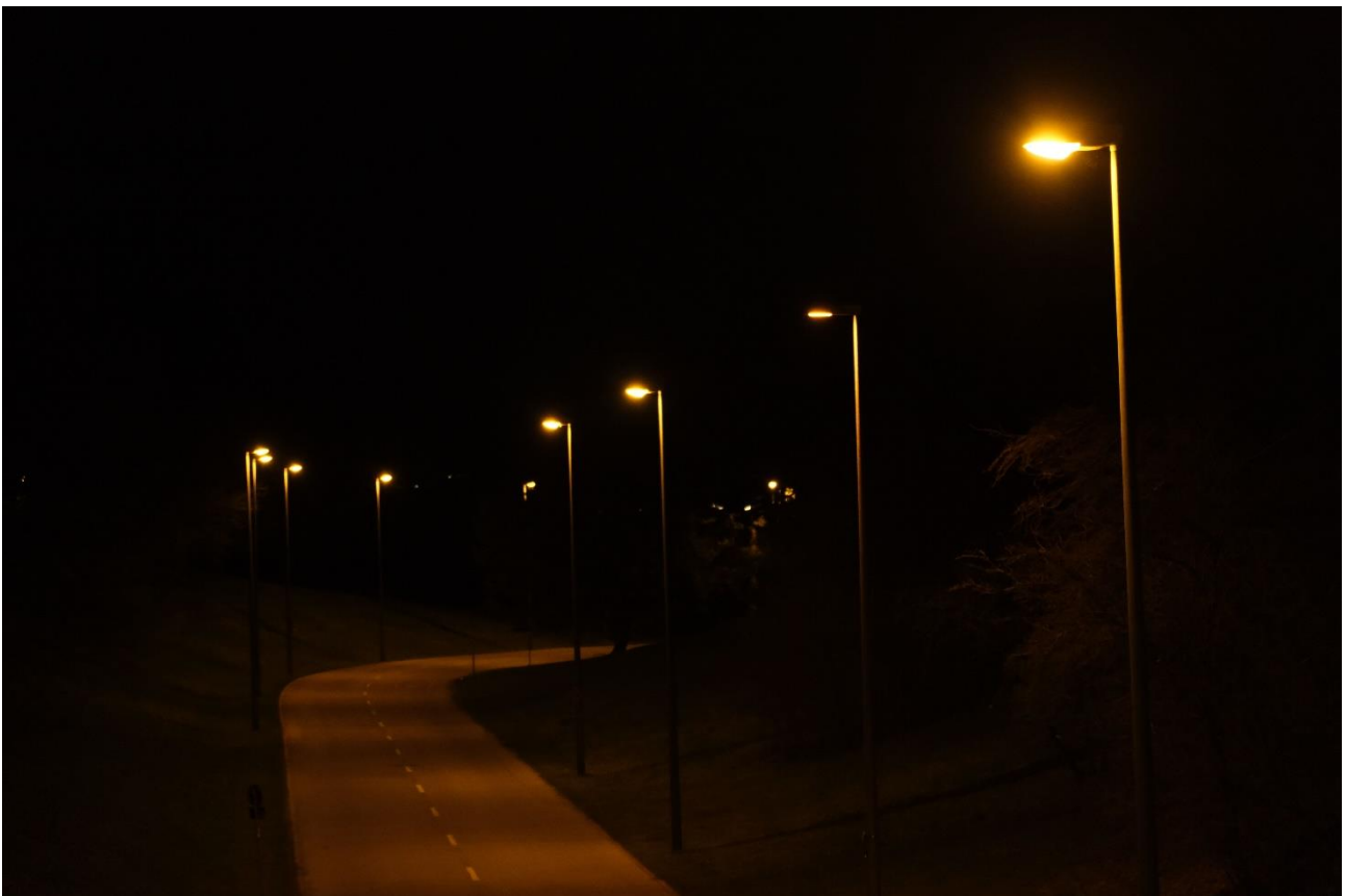
Foto (privat) 09.03.2024: Mastleuchten der Fahrstraße am Olympiaberg mit Lichtfarbe von ca. 2.200 Kelvin.
