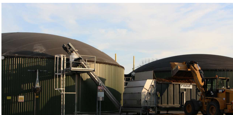
Biogasanlage am Gut Karshof
