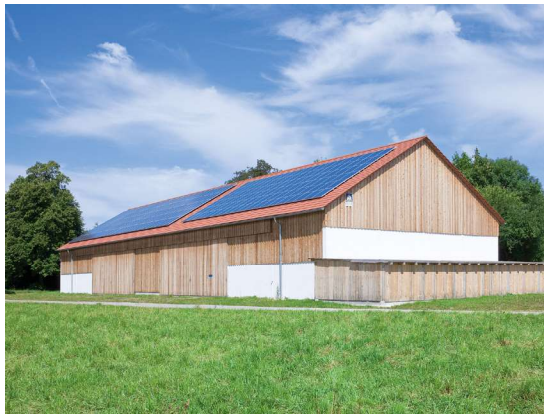
Photovoltaikanlage am Gut Großlappen
