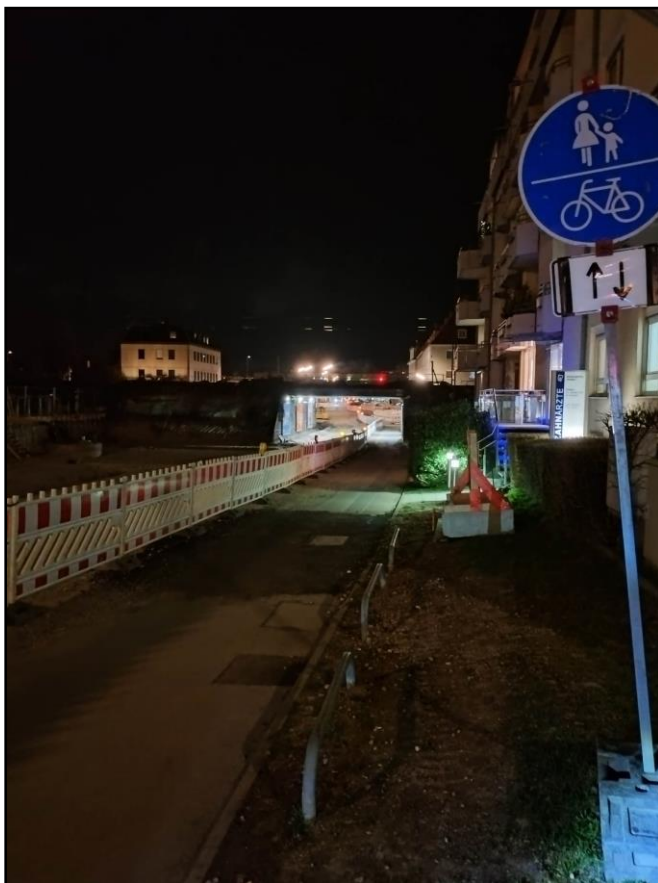
Abbildung 2: Abschnitt des provisorischen Geh- und Radwegs von Riesengebirgstr. in Richtung Nord-west bis Eisenbahnüberführung (Bild: K. Schacht, 11.03.2024)
