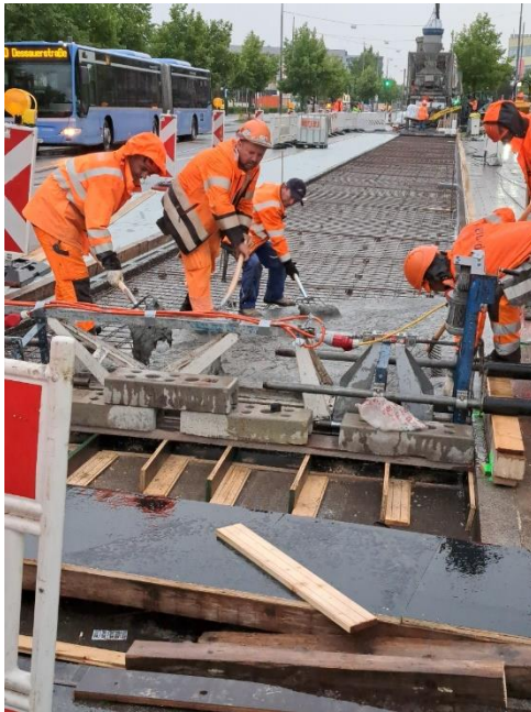
Abbildung 30 Einbringen des UHFB-Mischguts an der Hanauer Straße / Ecke Pelkovenstraße
