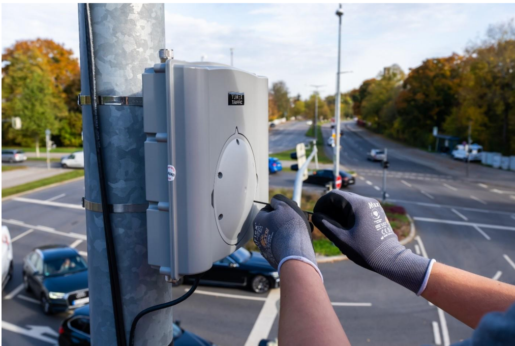
Abbildung 35 Montage und Inbetriebnahme einer RSU an einer Kreuzung
