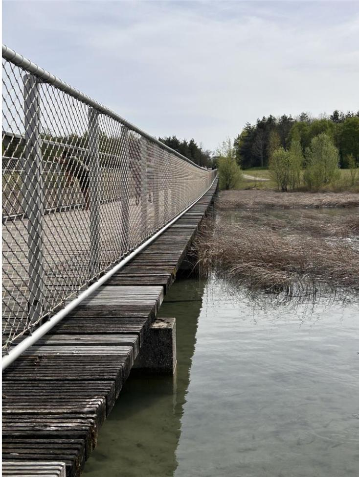
Foto 2 mit breiten Fundamentblöcken
