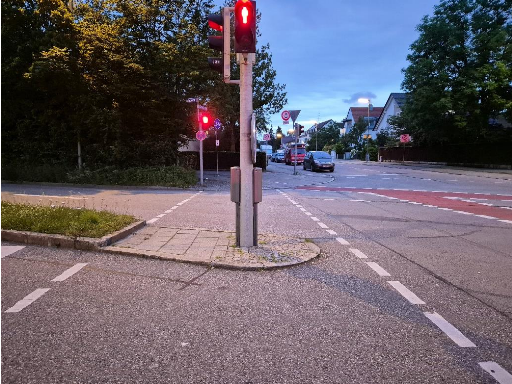
Schatzbogen südlich: Ampel steht mitten auf dem markierten Überweg.
