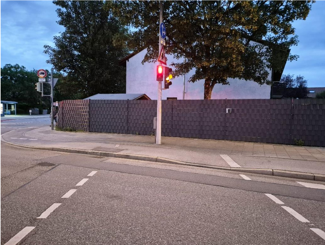
Schatzbogen südöstlich: Bordsteinabsenkung reicht nicht aus.
