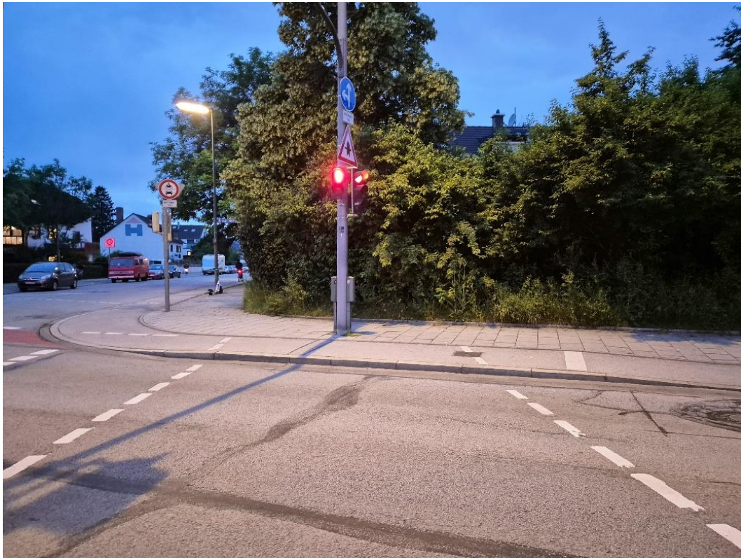
Schatzbogen nordwestlich I: Keine Bordsteinabsenkung an der Ampel.
