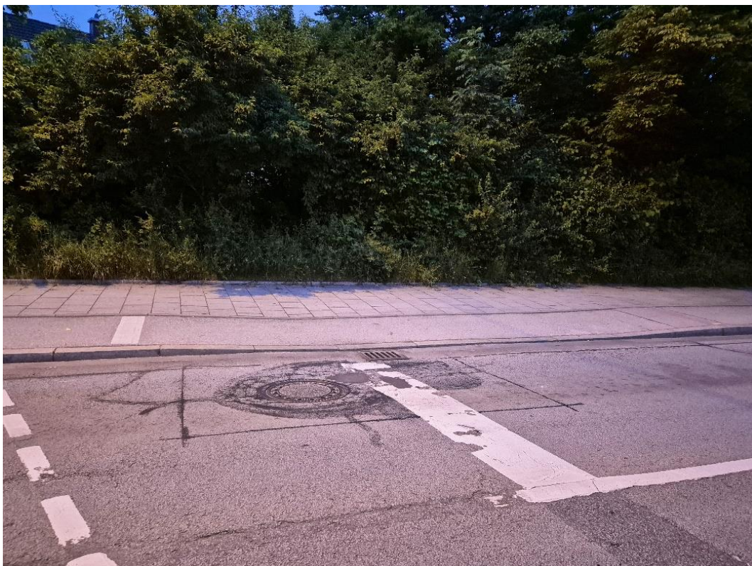
Schatzbogen nordwestlich II: Bordsteinabsenkung direkt vor Fahrspur und im Wartebereich der Fahrradfahrer.
