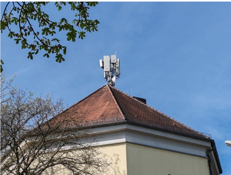
Der Hochbunker an der Sonnwendjochstr. mit bestehender O2-Sendeanlage Bilder: Stefan Hofmeir
