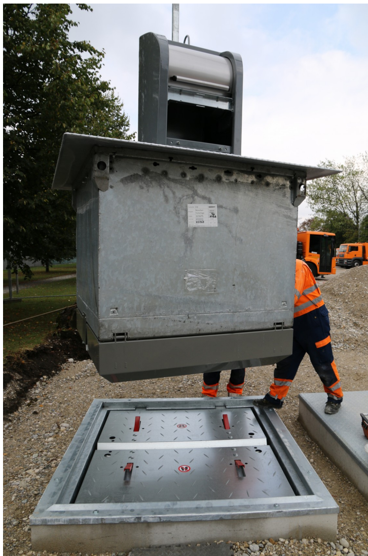
Der Unterflurbehälter samt Einwurfsäule wird vom Kran zur Entleerung aus dem Betonschacht gehoben
