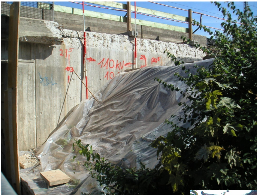
Platz für die 2. Röhre, Westseite. (Die 110 kV-Leitung kann leicht beiseite verschoben oder unter dem Gehweg verlegt werden, die Tunnelhöhe kann geringer sein als in der Kfz-Durchfahrt. Alternativ könnte die Fußgängerröhre aber grundsätzlich auch auf der N-Seite gebaut werden.)
