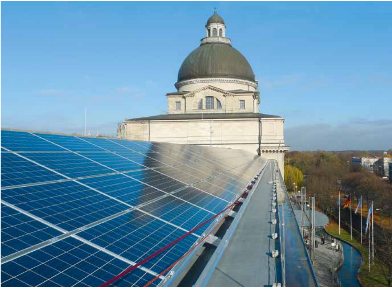
Hier war zunächst eine shedartig aufgeständerte Photovoltaikanlage geplant. Durch Anregung aus der Stadtgestaltungskommission konnte diese Solaranlage vollflächig in die Dachlandschaft integriert werden.
